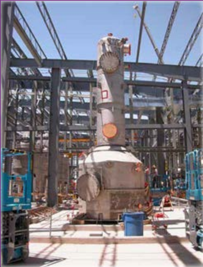
Planta de rentat de gasos (Scrubber)
