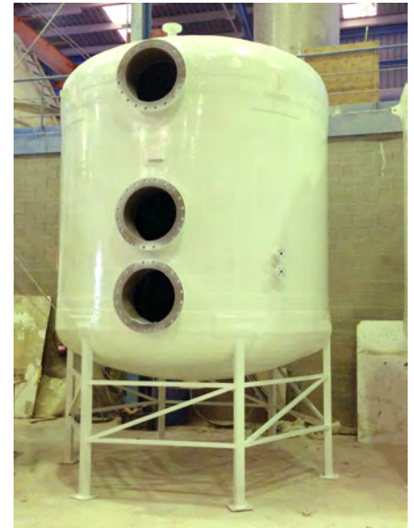
Dipòsit amb filtració de sorra vertical
