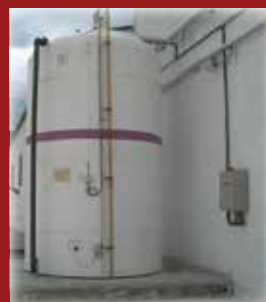
Dipòsits de doble paret calorífugats amb cable calefactor
