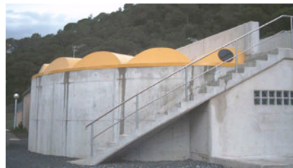
Coberta semicircular ondulant
