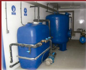
Equipos de filtración 50m<sup>3</sup>/h
