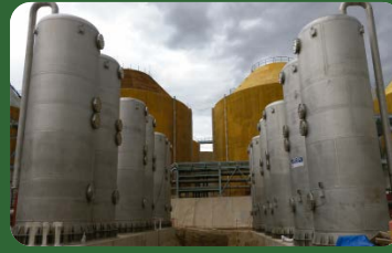
Centrales de bombeo y quema de Biogás
