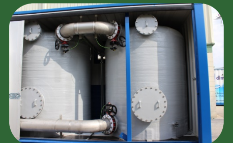
Limpieza y acondicionamiento de Biogás en Contenedor
