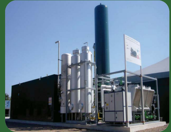
Limpieza y acondicionamiento de Biogás en Contenedor
