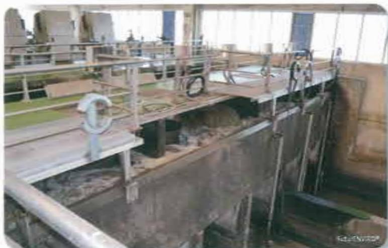
materia sedimentable. Estos tanques ocupan la quinta parte de la superficie requerida por un decantador convencional. Mediante unas rasquetas se arrastra el fango depositado en el fondo hacia unas pocetas que son purgadas periódicamente.
