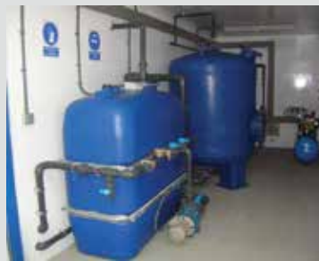
Equipos de filtración 50m 3 /h
