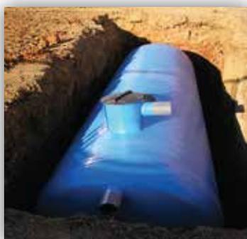
Los compactos SBR basados en el mismo principio tecnológico que los compactos DOT de aireación prolongada pero en un solo compartimento. En la misma cámara secuencialmente airea y decanta.
