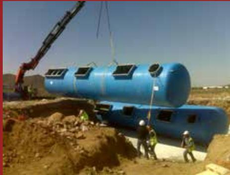
Depósitos horizontales para enterrar, fabricados en PRFV con los dos fondos toriesféricos y aros de refuerzo en PRFV.
